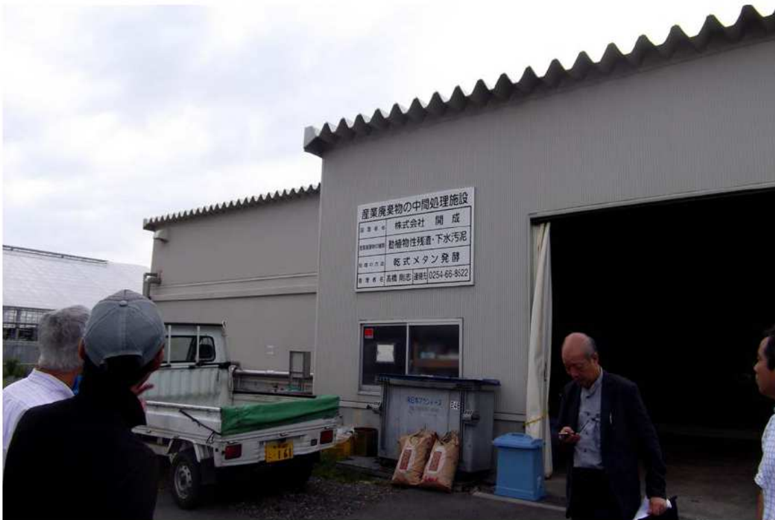
瀬波バイオマスエネルギープラント
