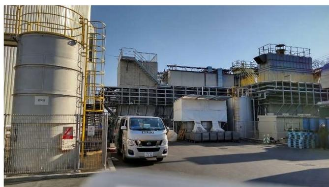
脱硫装置（左側）と排水処理装置（中央）
