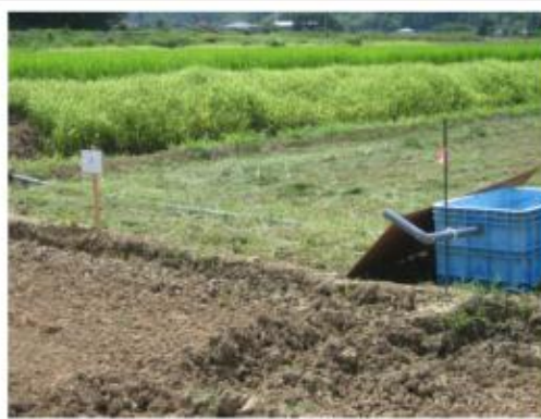
写真-B: 導水塩ビパイプラインとゼオライト水槽
