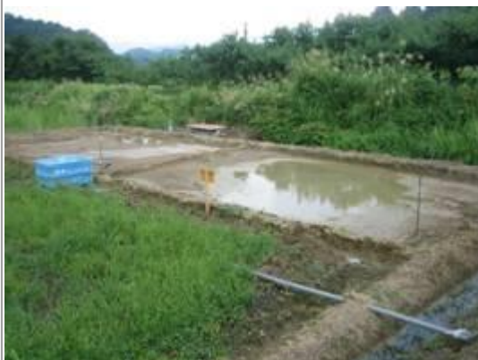
水田除染実施状況
