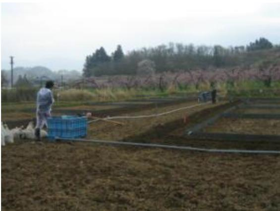
写真3 代かき水配管工事 手前がセオライト水槽
