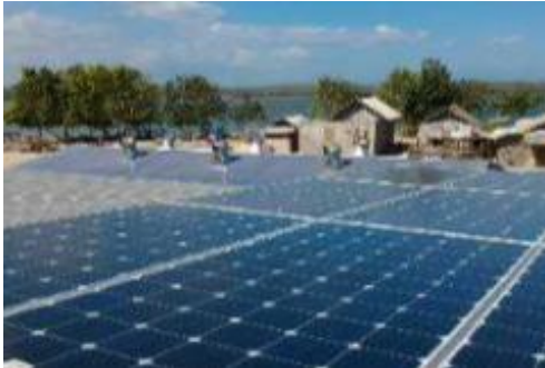
加工工場屋上に設置された太陽光パネル
