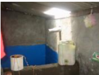
雨水溜め(生活用水・飲料水)
