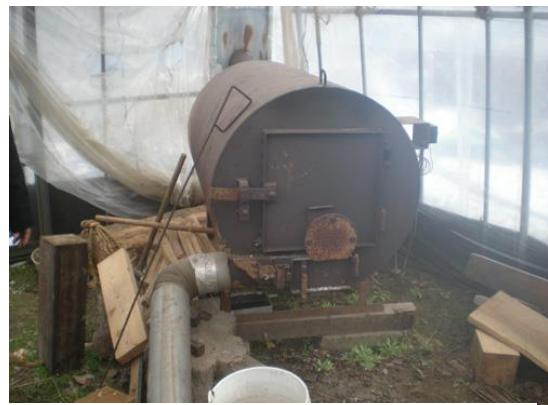
写真 3-5-2 木材燃料使用の燃焼装置
