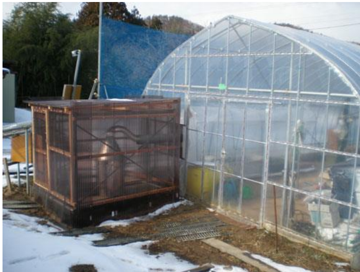
写真 3-5-5 手造りのバイオガス・ハウス暖房試験設備
