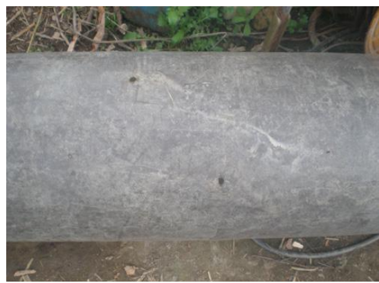
写真 3-5-4 ダクト孔から噴出するガス
