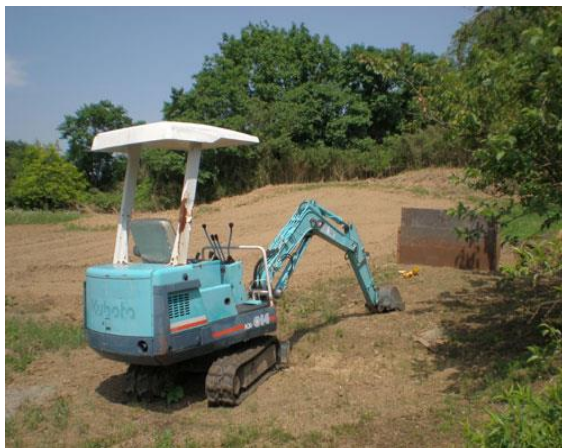
写真 1-2-1 深い耕作のための重機
