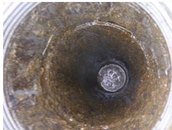
発酵槽投入口から見た底部
