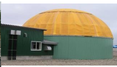
ガスホルダー一体型 メタン発酵槽
