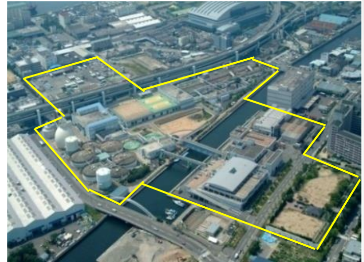
神戸市の東灘下水処理場の全景
