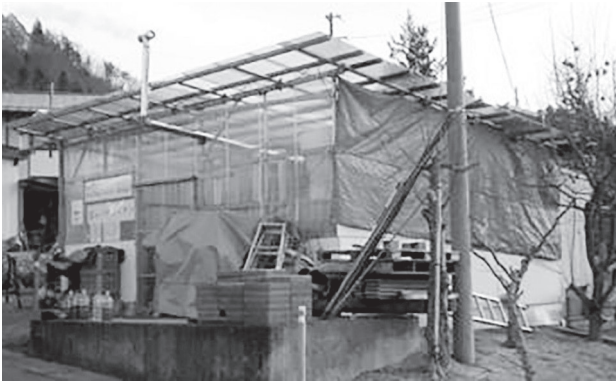
メタン発酵プロジェクトの拠点「大沼プラント」外観
